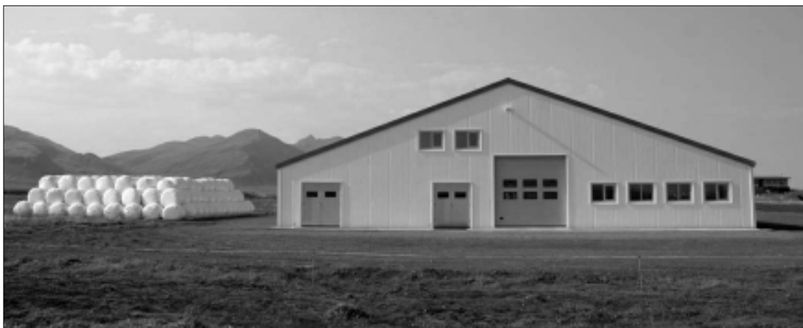
Kennslu- og rannsóknafjosið á Hvanneyri sem tekið var í notkun síðsumars 2004.
