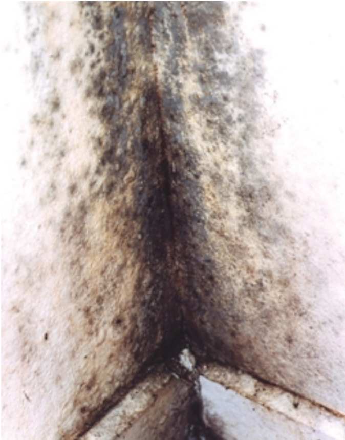
Myglusveppir í horni bak við bókaskáp þar sem raki þéttist í herbergisloftinu ofan við og lak niður vegginn.
