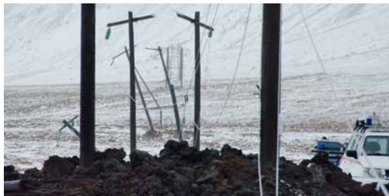
Í upphafi ársins var unnið að viðgerðum á flutningslínunum Landsnets á sunnanverðu Snæfellsnesi eftir tjón vegna Ísingaveðurs.
