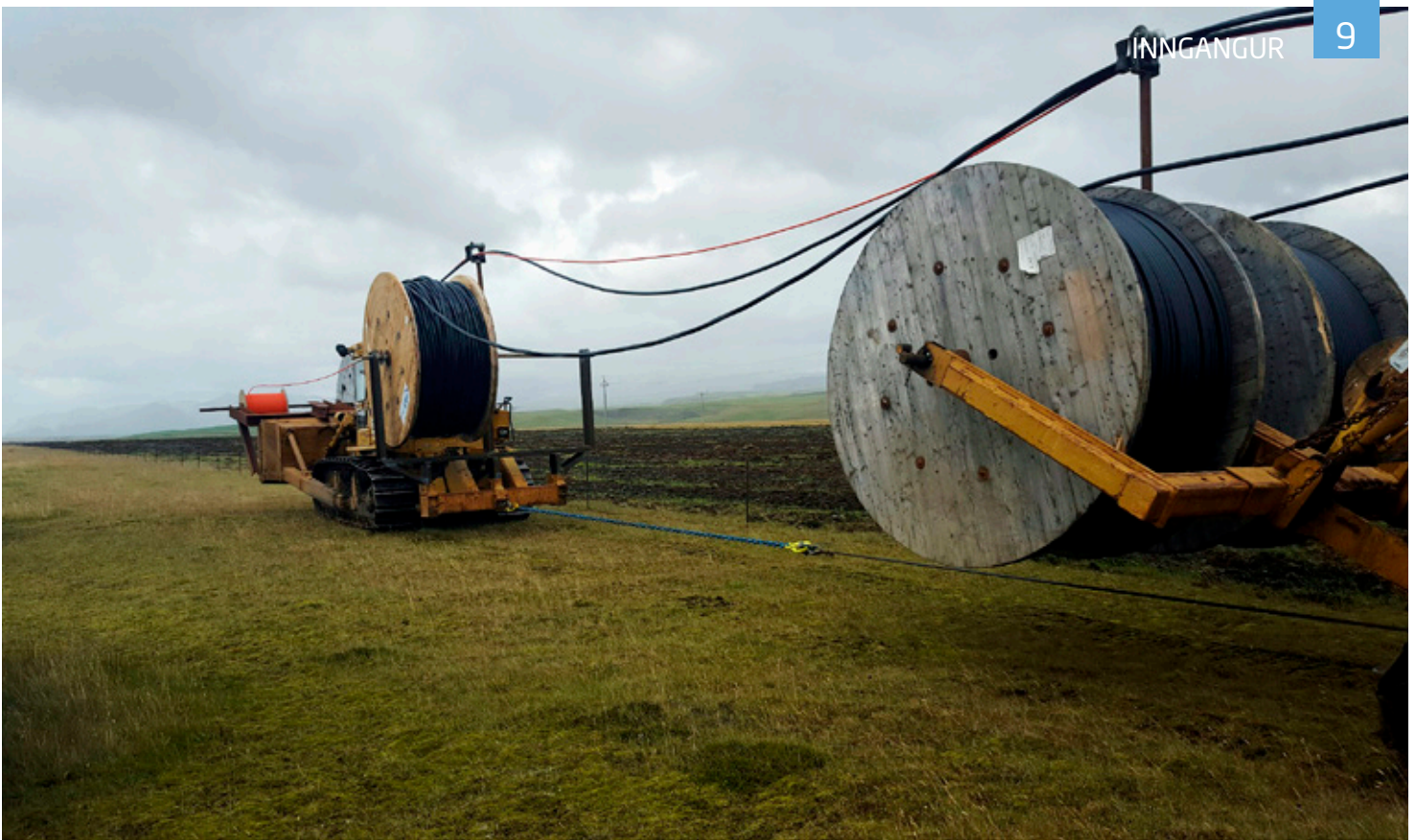
Plæging 33 kV strengs í Mýrdal.
