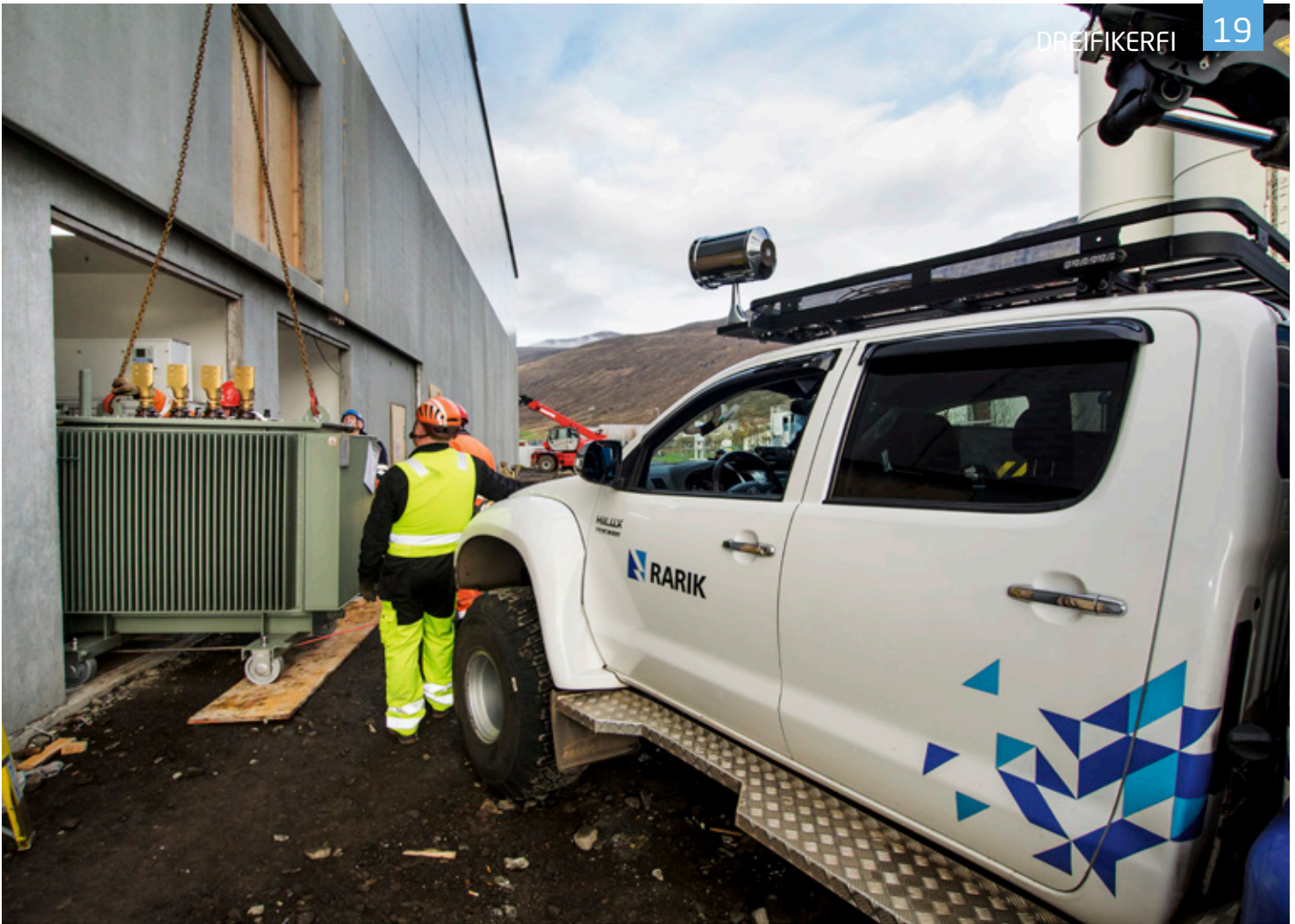
6 MVA spennistöð komið fyrir í nýju uppsjávarfrystihúsi Eskju á Eskfirði.
