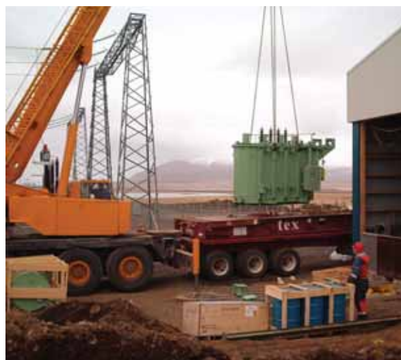
Með tilkomu nýs 66 kV spennis í aðveitustöðinni að Brennimmel er gert ráð fyrir að spenna notenda á svæðinu sunnan Skarðsheiðar, í Hvalfirði og Kjósarhreppi verði stöðugri
