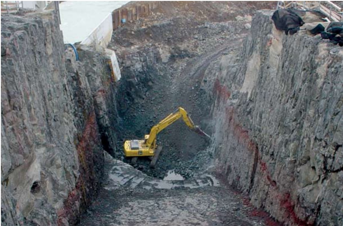
Framkvæmdir við stækkun á Lagarfossvirkjun
