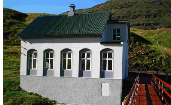
Stöðvarhús Fjarðarselsvirkjunar eftir gagngerar endurbætur árið 2003
