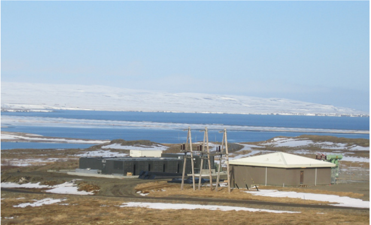
Aðveitustöð Vopnafirði ásamt nýjum varavélum í gámum.
