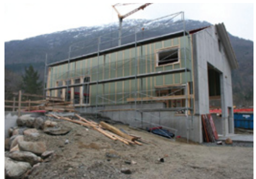
Frá virkjanaframkvæmdum Bláfall Energi í Noregi
