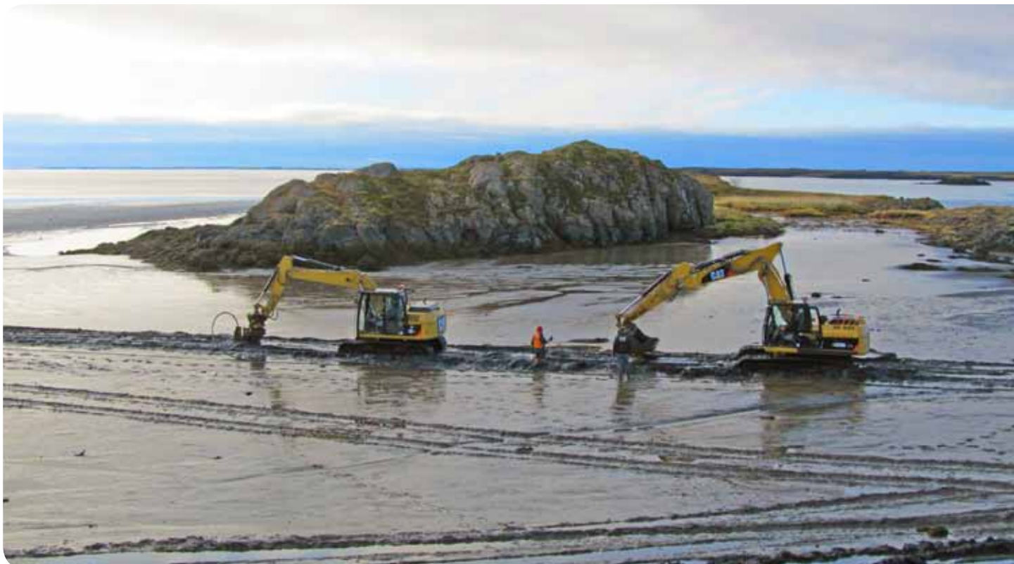
Aðstæður við lagningu háspennustrengja geta stundum verið erfiðar. Í síðustu viku októbermánaðar 2011, var háspennustrengur plægður niður í sundið á milli Borgarness og Brákareyjar á stórstraumsfjöru.
