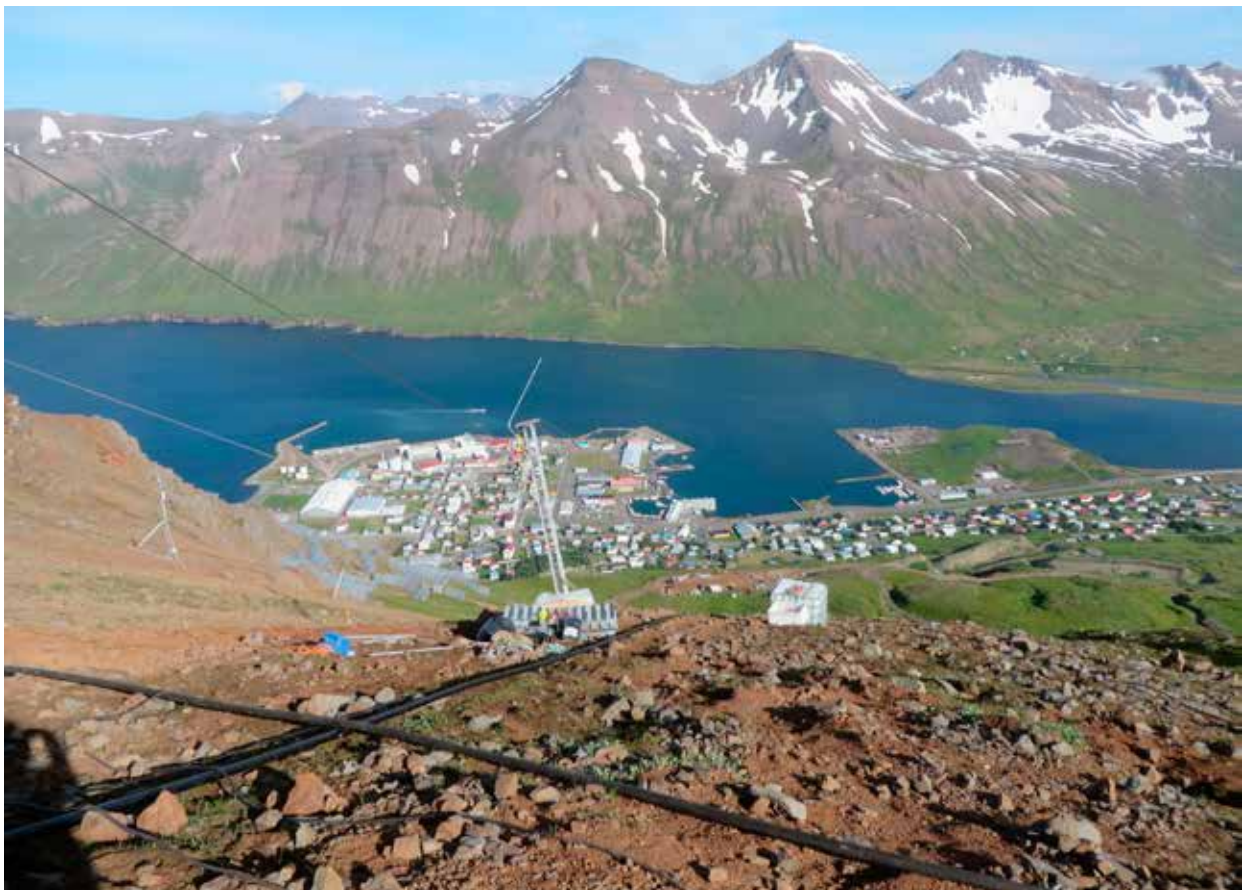
Uppsetning stoðvirkja, á upptakasvæðum snjóflóða til snjóflóðavarna í N - Fífladölum ofan byggðar á Siglufirði.
