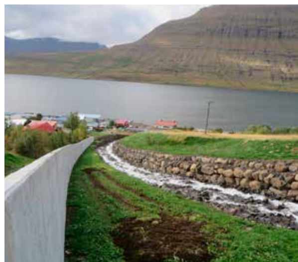
Krapaflóðsvarir í og við farveg Hlíðarendaár, Eskifirði.
