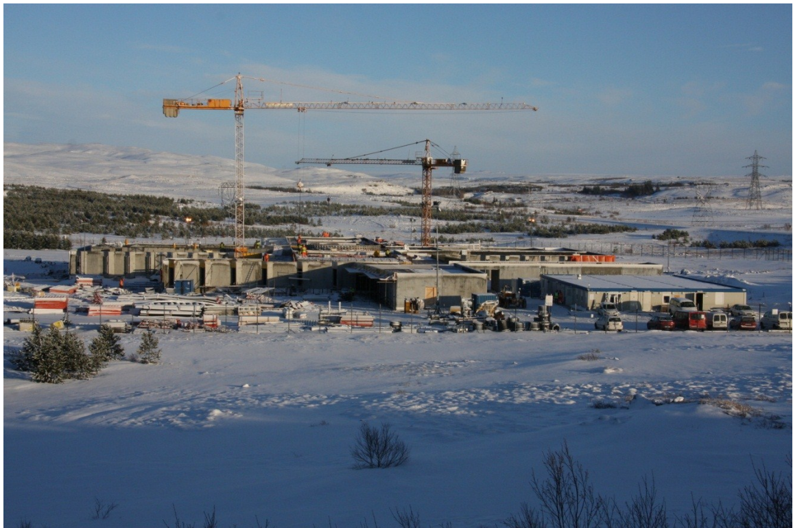
Framkvæmdir við Fangelsið á Hólmsheiði
