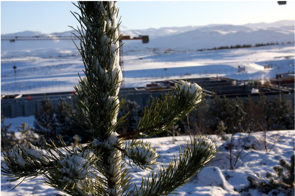
Framkvæmdir við Fangelsið á Hólmsheiði 2014 - 2015
