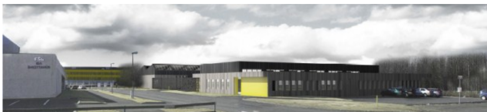
Stækkun verknámsstöðu við Fjölbrautarskóla Suðurlands
