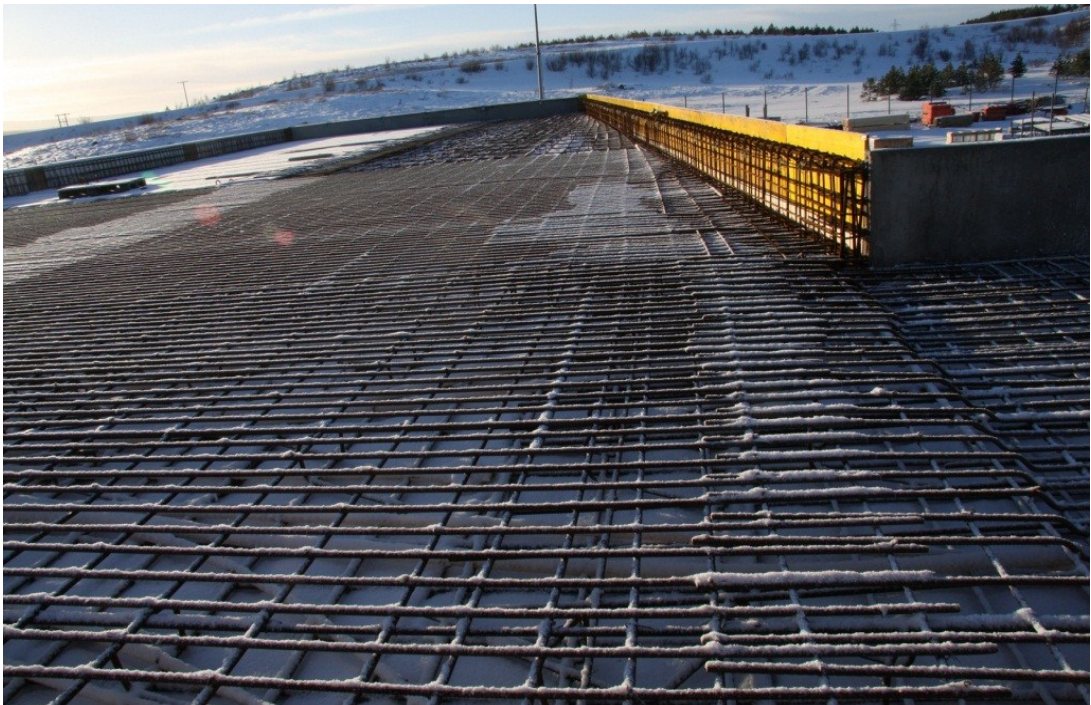
Framkvæmdir við Fangelsið á Hólmsheiði
