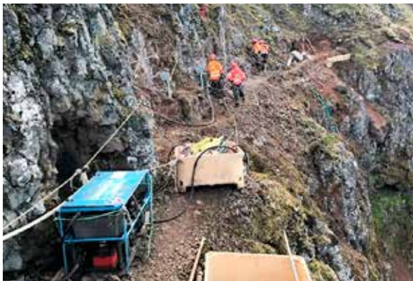
Uppsetning stoðvirkja í Kubba.
