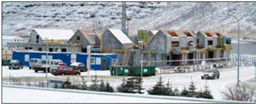
Hjúkrunarheimilið í Fjarðabyggð í byggingu.
