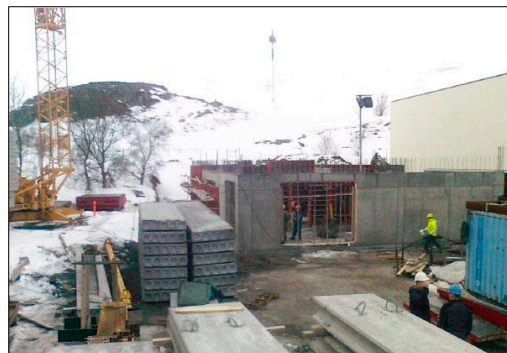
Háskólinn á Akureyri, 5. áfangi, í byggingu.
