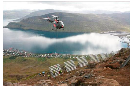
Uppsett stoðvirki í Tröllagili, Neskaupstað.
