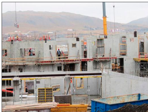
Framhaldsskólinn í Mosfellsbæ í uppsteypu.
