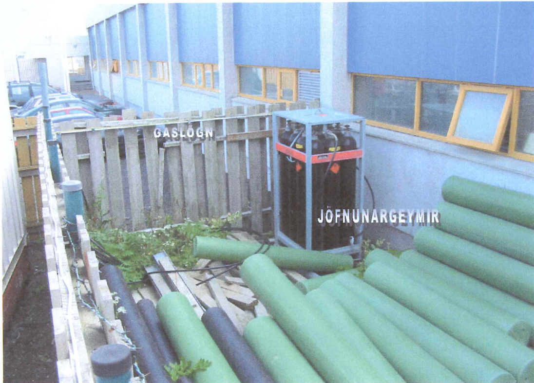
Mynd 3. Lögn frá gámi og inn í hús, jöfnunargeymar fyrir metan
