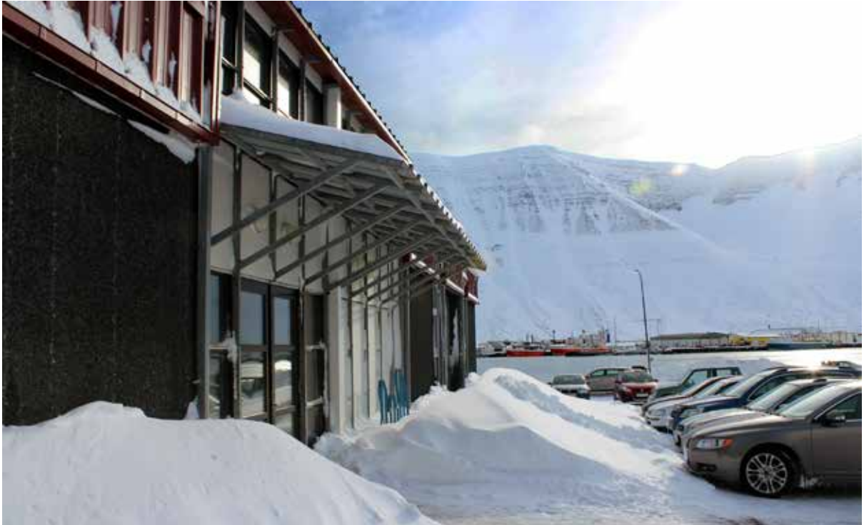
Verkmentahúsið við Mennta- skólann á Ísafirði
