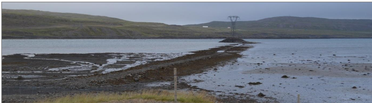
Mynd 6.12.34. Rafmagnslína sem liggur yfir Þorskafjörð. Tekið í suðaustur, í átt að Kinnarstöðum (ljósmynd: NAVE/HBA).
