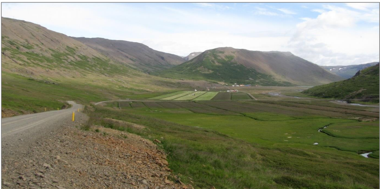
Mynd 1.10.2. Vestfjarðavegur við Gufudal (ljósmynd: HA, 2012).
