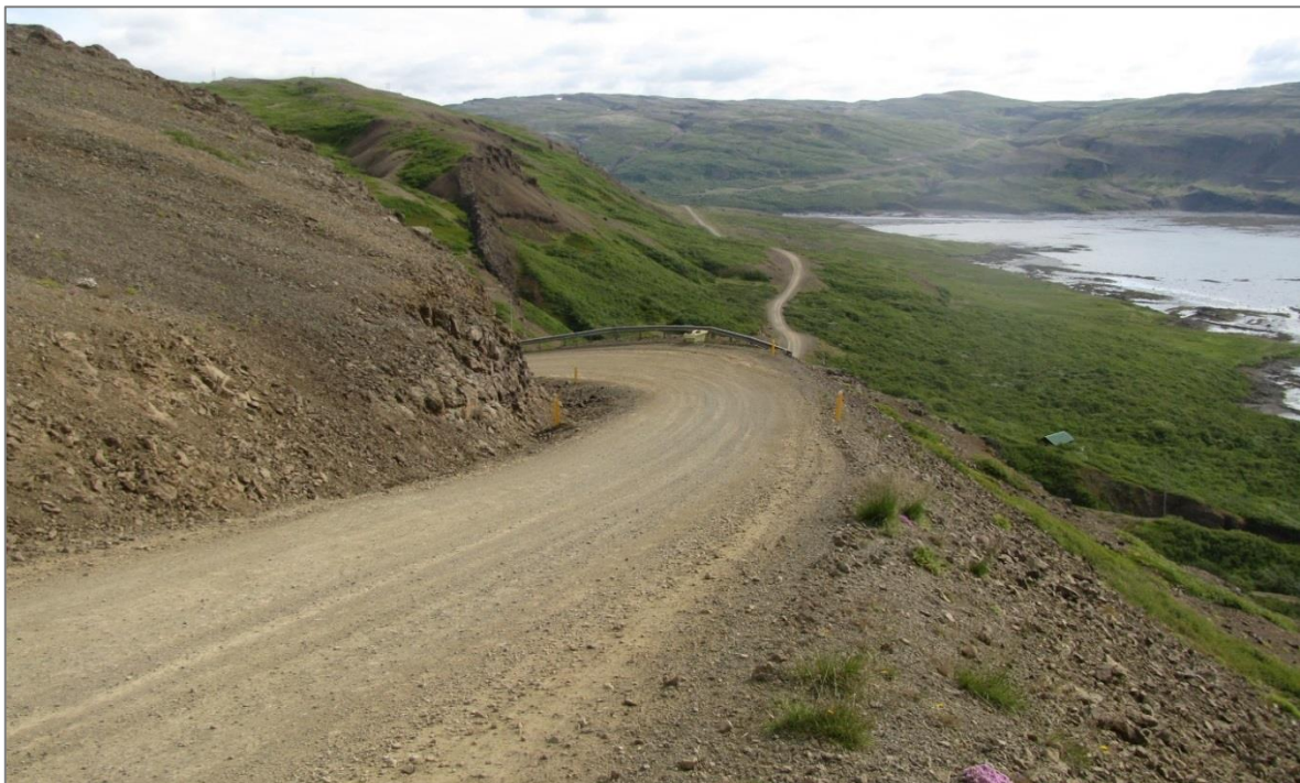
Mynd 1.4.1. Kröpp beygja á núverandi vegi á Ódrjúgshálsi Djúpafjarðarmegin (ljósmynd: HA, 2012).
