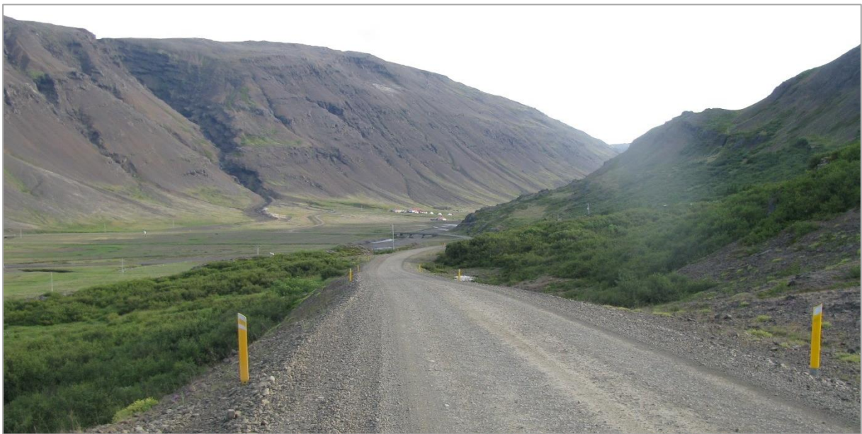
Mynd 1.10.1. Vestfjarðavegur við Djúpadal (ljósmynd: HA, 2012).
