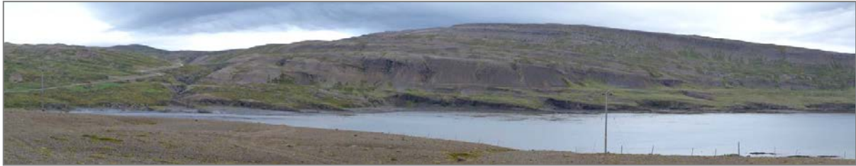
Mynd 6.12.52. Séð yfir Hjallaháls og framkvæmdasvæði leiðar H1 (ljósmynd: NAVE/HBA).
