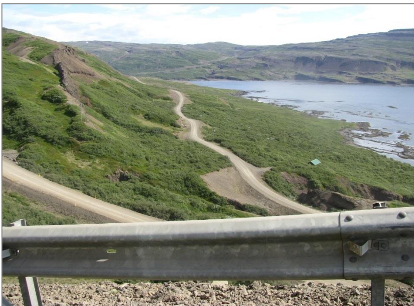
Mynd 2.3.2. Vestfjarðavegur (60) um Ódrjúgsháls að austanverðu (ljósmynd: HA, 2012).
