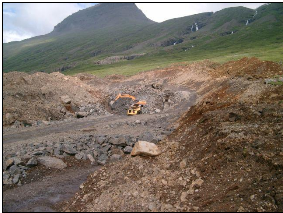
Mynd 4.4.1. Unnið í forskeringum í Fáskrúðsfirði (ljósmynd.: Sigurður Oddsson, júní 2003).
