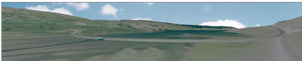
Mynd 6.12.81. Leið D2 í botni Djúpaþfjarðar. Sami útsýnisstaður og á mynd 6.12.80 (þrívíddarmynd: Vegagerðin/ HSH).
