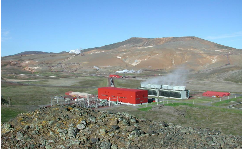
Mynd 4 Núverandi mannvirki Kröfluvirkjunar í Leirbotnum. Horft til norðausturs (Mannvit hf)
