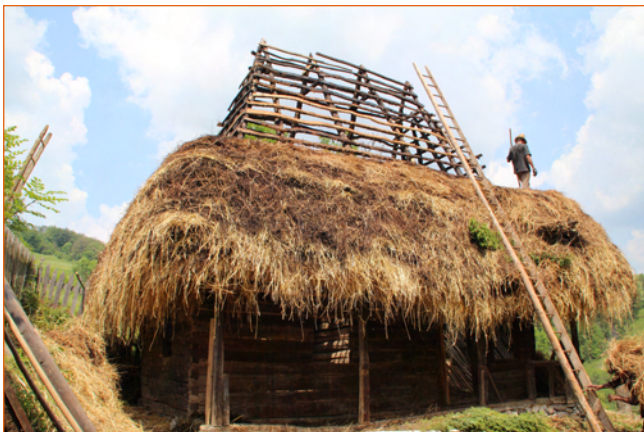
Mynd 16. Unnið að byggingu húss í verkefninu Vast-view í Rúmeníu.
