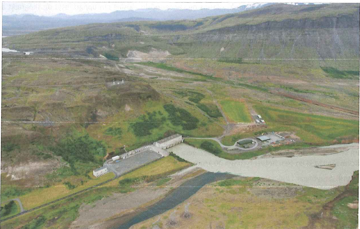
Mynd 2. Séð yfir núverandi stöðvarhús og tengivirki Búrfellsvirkjunar. Mynd: Emil Þór Sigurðsson.
