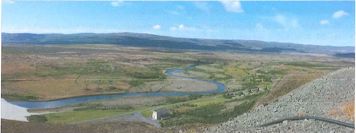
Mynd 6. Horft norður yfir núverandi tengivirki og syðsta hluta núverandi starfsmannaíbúða.
