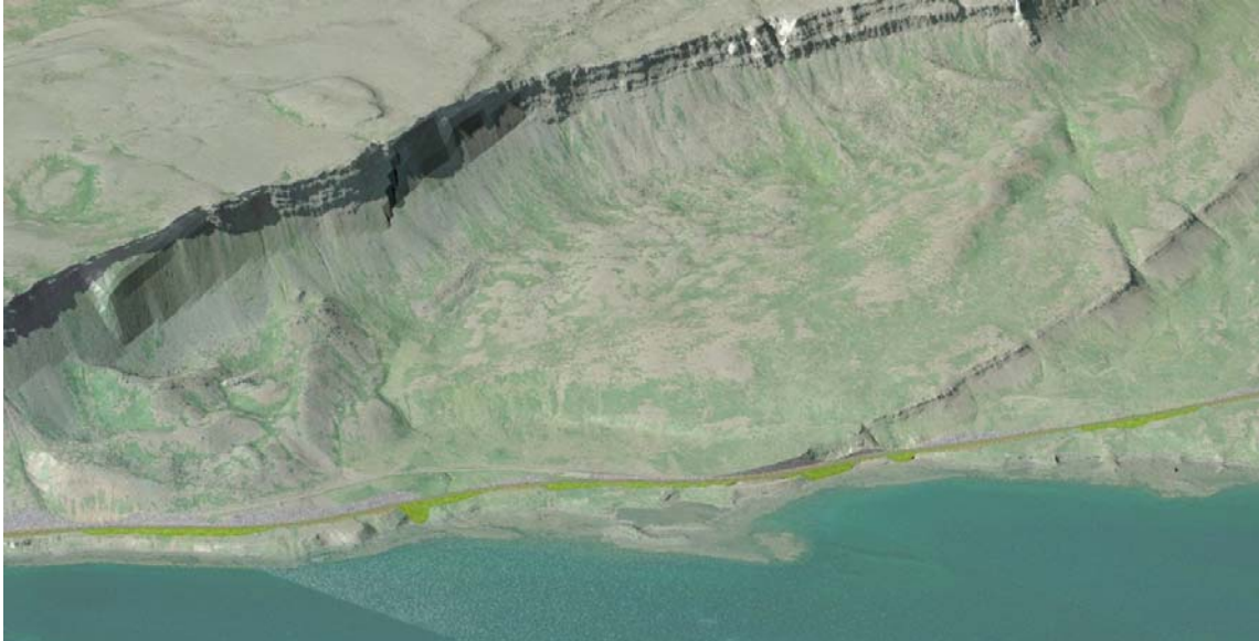
Þrívíddarmynd 12. Vesturhlíð Kerlingarfjarðar á milli vegstöðva 4400-6900. Grænt= fylling, grátt= skering, brútt= raskað svæði. Myndvinnsla: Halldór Sv. Hauksson.
