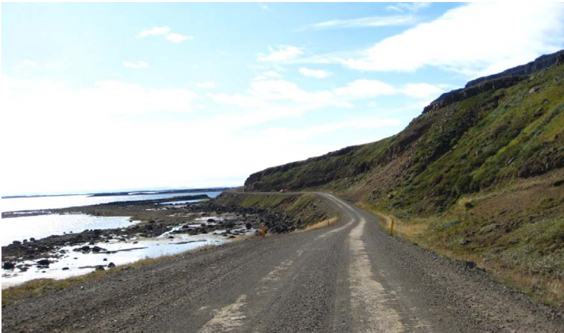
Mynd 27. Hamar á milli vegstöðva 5500-5600, skorið verður af hamrinum auk þess sem fyllingar verða settar niður í fjöruna á um 90m kafla þar sem hún kemur mest inn (sjá þrívíddarmynd 13).
