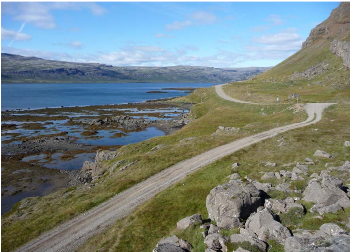
Mynd 33. Horft yfir víkur Kjálkafjarðarvestan megin við Litlanesi. Myndin er tekin af hamrinum sem er neðan núverandi vegstæðis. Sjá má hluta efri hamarsins í hægra horni myndarinnar en vegurinn í forgrunni er að útsýnisstað á vestanverðu nesinu.
