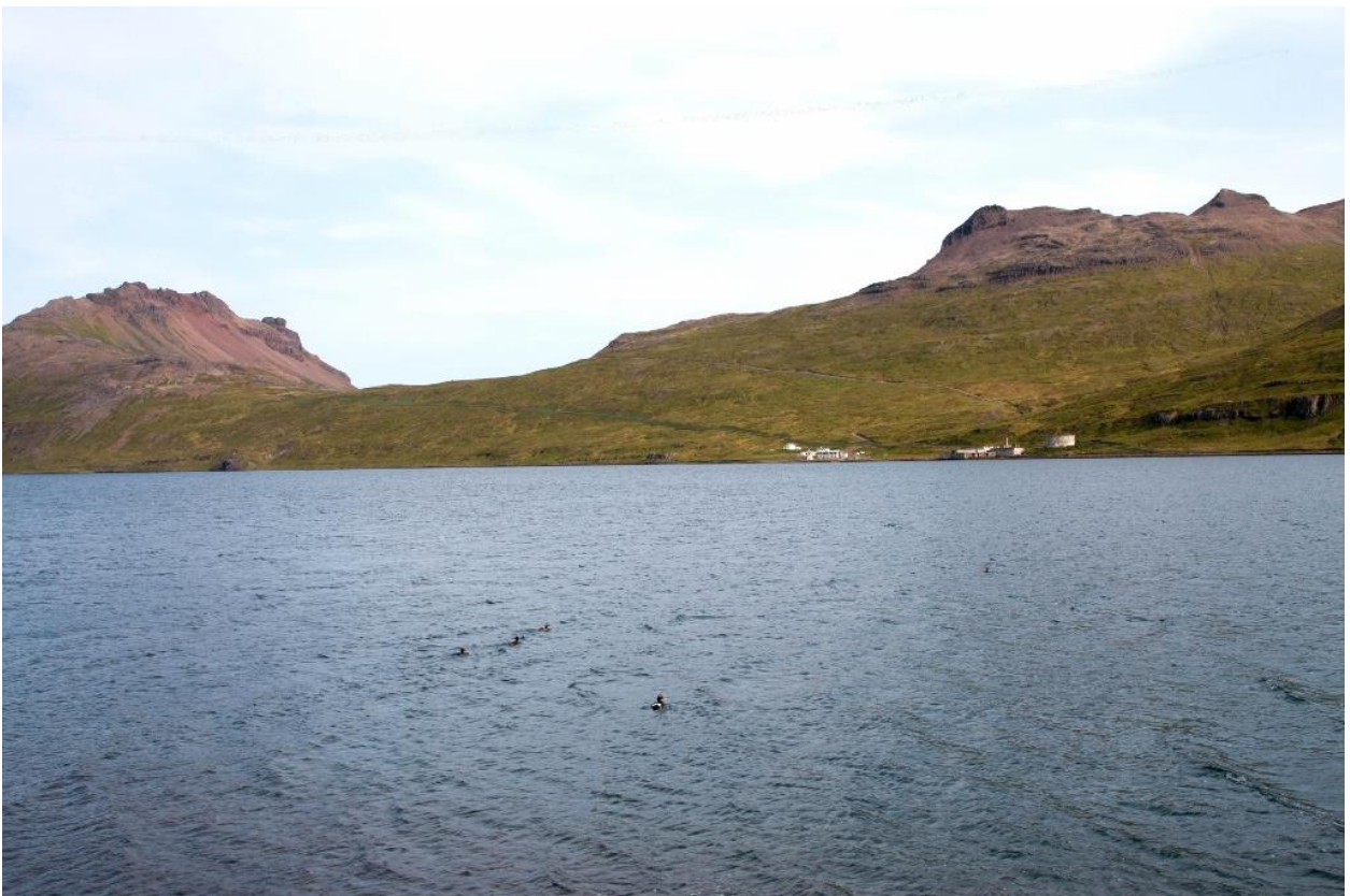
Mynd 7.56 Eyri í Ingólfssfirði. Sama sjónarhorn og að ofan en nýr vegarkafli ásamt fyllingum og skeringum hefur verið tölvuteiknaður inn á myndina. Ljósmynd Verkís/EV
