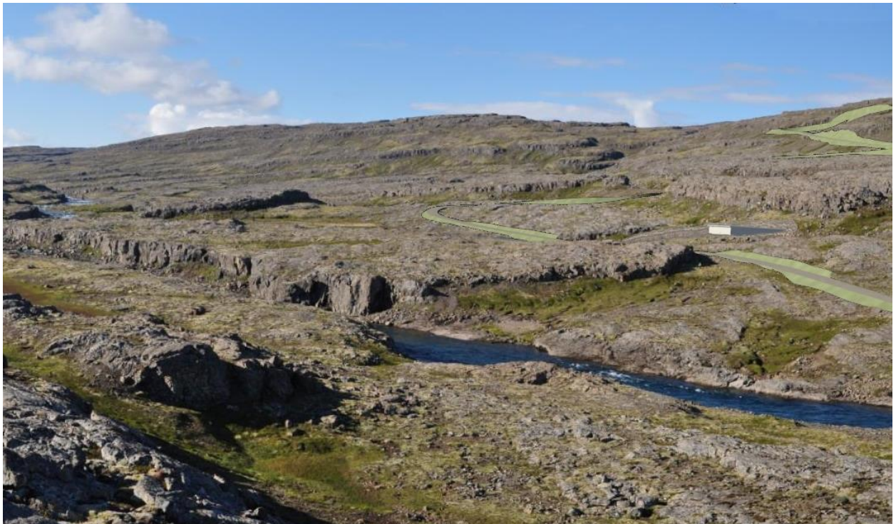
Mynd 7.41 Sama sjónarhorn og hér að ofan. Sjá má aðkomuvegi að virkjuninni hlykkjast upp fjallið og efsta hluta aðkomuhússins þar sem það stendur niðurgrafið í skurði framan við aðkomugöngin. Litir mannvirka hafa verið ýktir til að sjást betur. Vinnubúðasvæði er fyrirhugað á miðri mynd á sléttu svæði milli árinna og vegarins. Ljósmynd Verkís/SPS.
