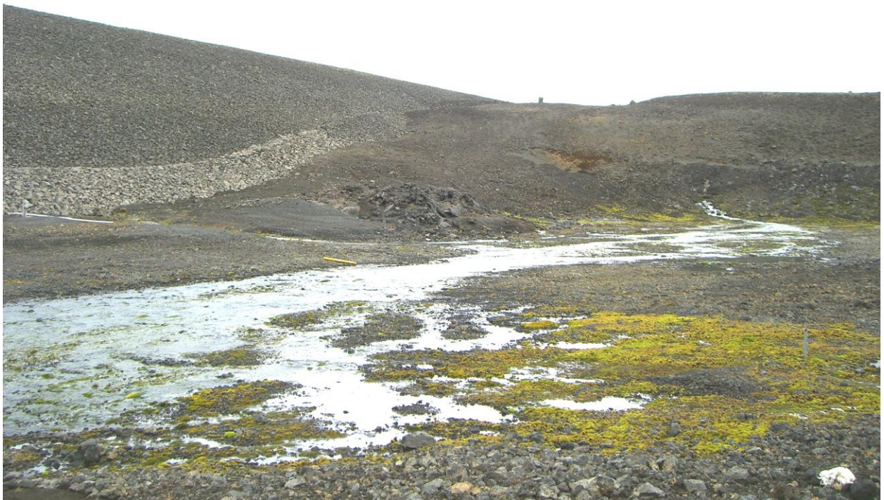
Mynd 7.44 Frá Hágöngustíflu. Myndin sýnir hvernig jarðvegsstífla muni mögulega líta út. Stífluendi er vinstra megin á myndinni og tágrjót neðst í stíflunni er ljóst að lit.
