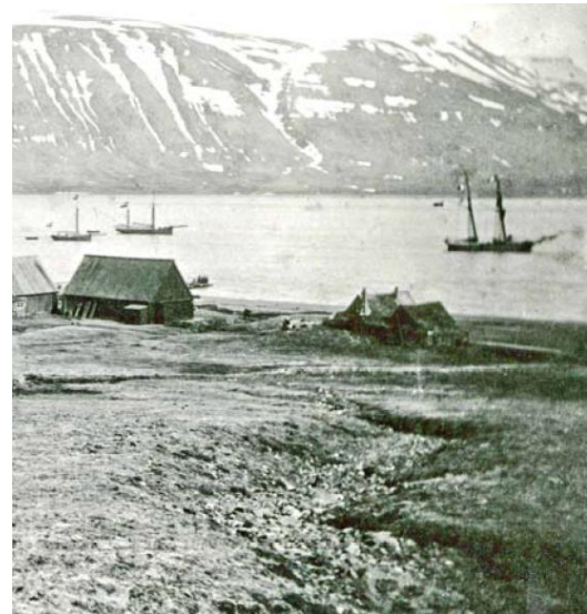
Mynd 17. Á myndinni má sjá Salthúsið sem enn stendur og við hliðina á því er Beykihúsið gert út torfi og grjóti. Þingeyri um 1885. Ljósmynd í Þjms.
