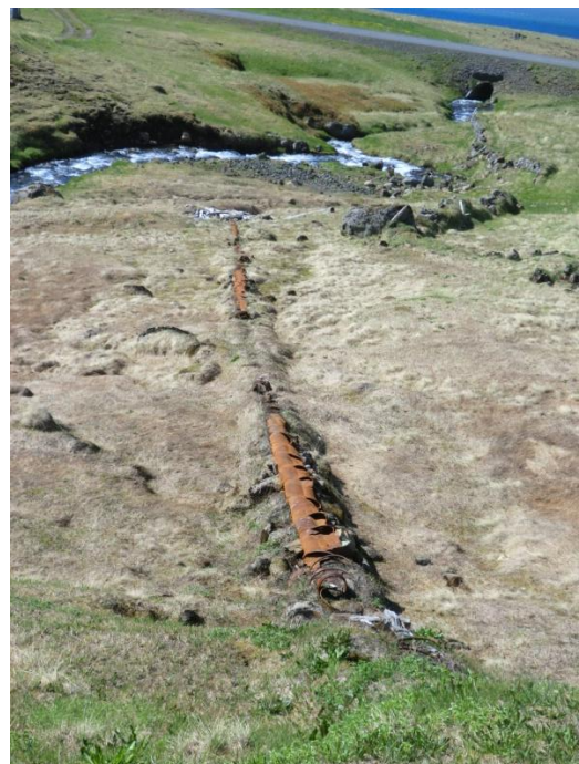
Mynd 1. Rörið sem lá niður að rafstöð. Ljósmynd: MHH.
