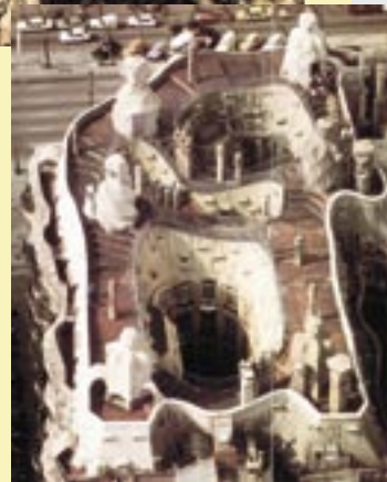
La Pedrera (1906-1910). Arkitekt: Gaudí.
