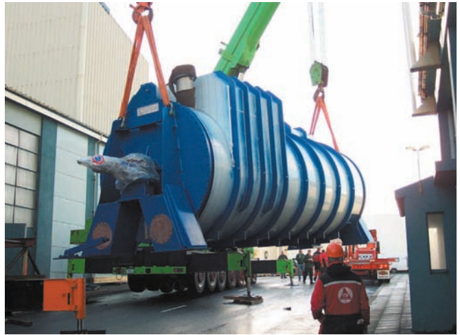
Gufuþurrkaranum komið fyrir í fiskimjölsverksmiðjunni. Hann vegur 110 tonn og er þyngsti hlutur sem Samskip hafa flutt til Íslands.
