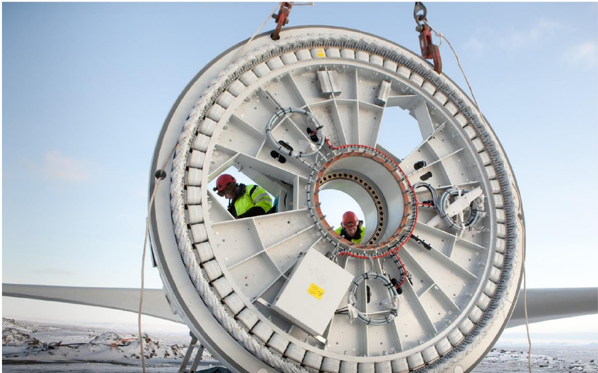
Mynd 6 Rafalar í rannsóknarvindmyllunum á Hafinu eru gírlausir. Ljósmynd: Landsvirkjun.
