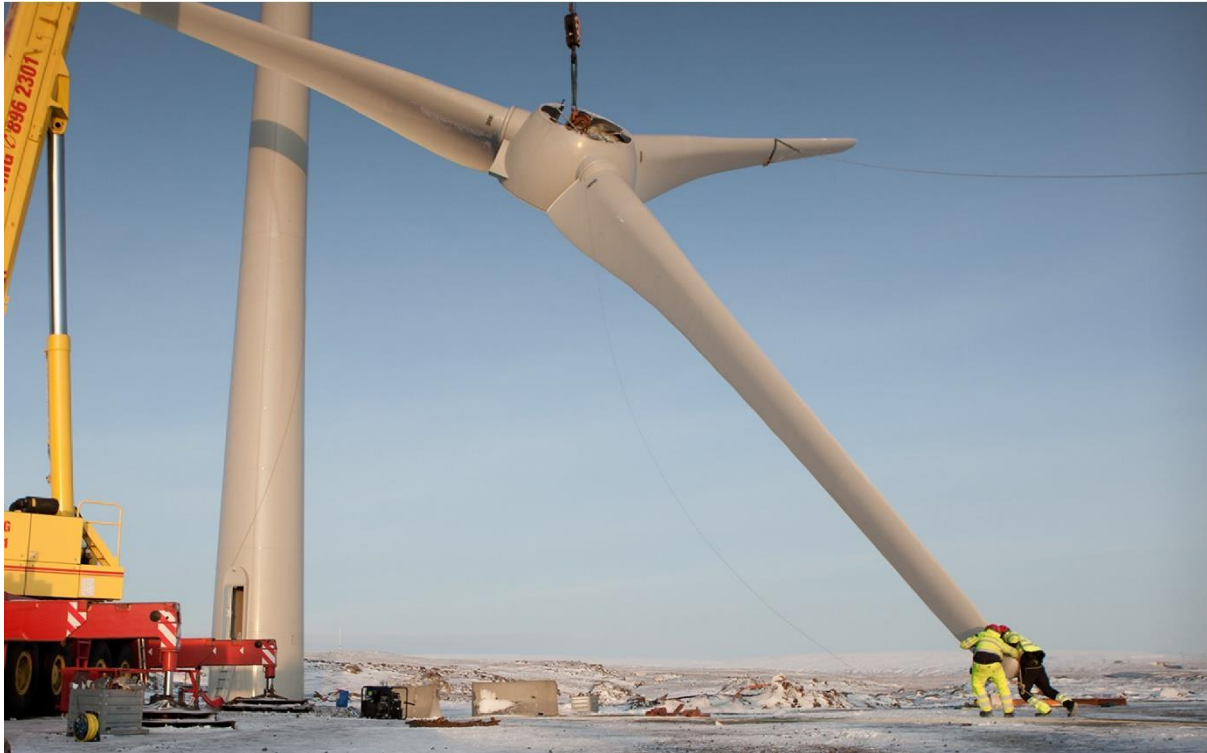
Mynd 4 Hver spaði á E-44 vindmyllunum á Hafinu er 22 m að lengd. Ljósmynd: Landsvirkjun.
