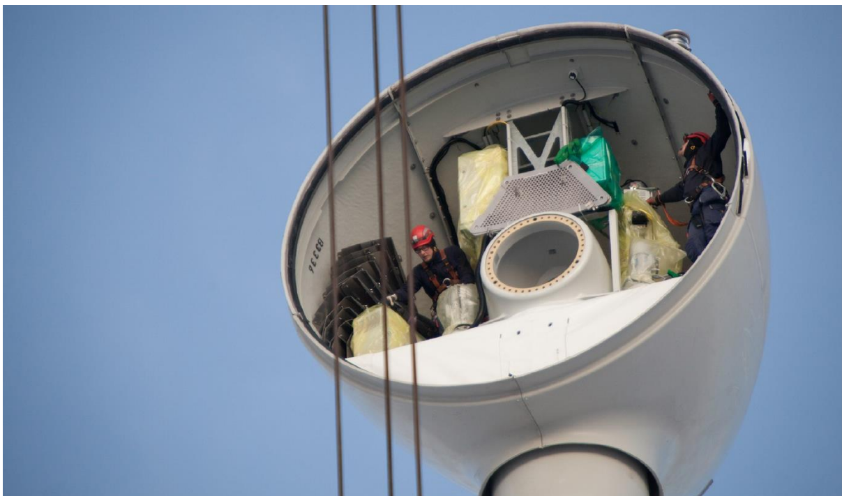
Mynd 5 Vélarhúsið situr efst á vindmylluturninum í 55 m hæð. Ljósmynd: Landsvirkjun.
