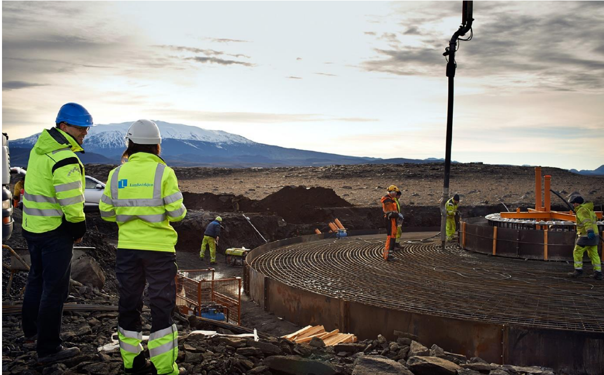
Mynd 8 Steypt í undirstöður rannsóknarvindmyllu á Hafinu. Ljósmynd: Landsvirkjun.
