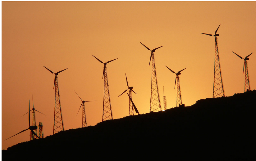
Mynd 19: Turn sumra vindmylla er reistur á grind.
