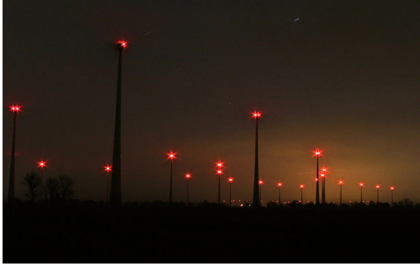
Mynd 22: Öryggislýsing vegna vindmylla er ýmist hvít eða rauð eða hvoru tveggja.
