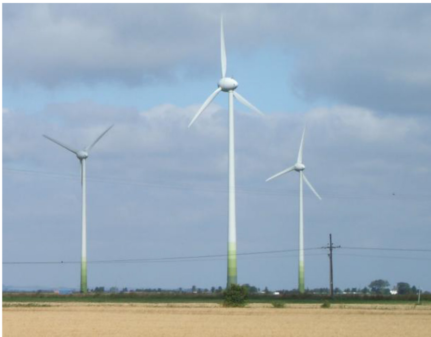
Mynd 21: Stundum er turn vindmylla málaður í öðrum lit neðst og smám saman látinn blandast við grúa litinn með það markmið að vindmyllur falli betur inn í umhverfið.
