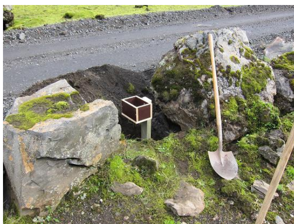
5. mynd. Bifreiðateljara komið fyrir í vegkanti.
