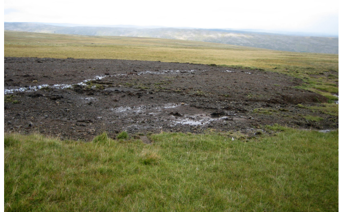
Náma í grónu landi sem gengið hefur verið vel frá. Athugið samt vatnsrás eftir miðri námunni.
