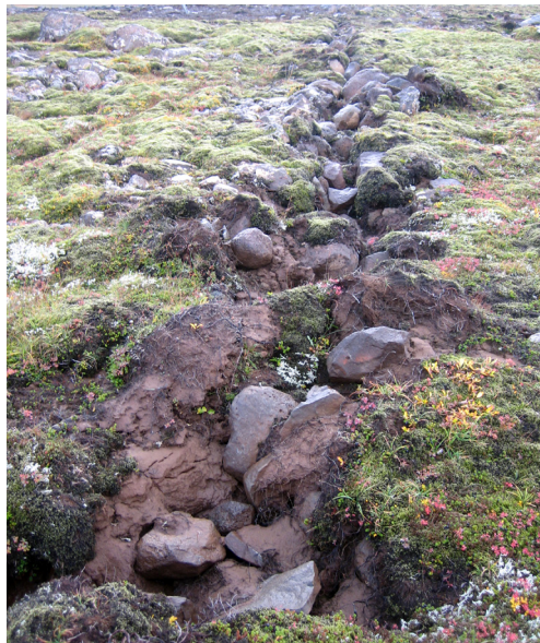
Sár eftir plógfur vegna lagningar jarðskautsborða.
