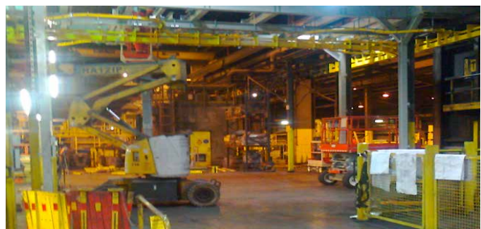
Framkvæmdasvæðið kl 18:21. Allt komið upp nema ein mjó gul keðjubraut sem þarf að leggja yfir þvera brúna.
