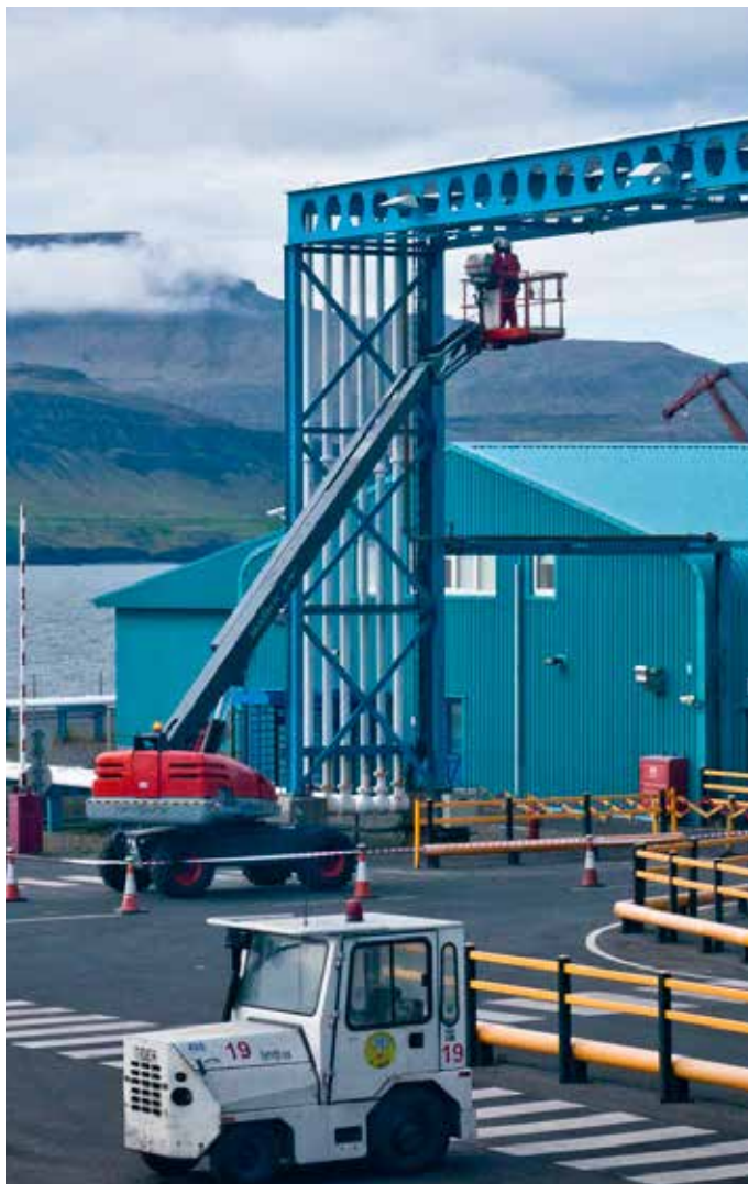
Félagarnir í spjótlyftu og búnir að merkja vinnusvæðið með borðum, keilum og útdraganlegum grindum Rafvirkjarnir knáu, Birkir Sigurðarson til vinstri og Adam Finnsson
