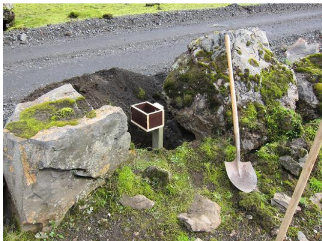
11. mynd. Bifreiðateljara komið fyrir í vegkanti við Eldgjá.
