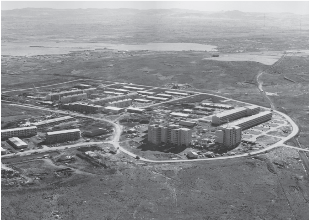
Breiðholt hf. – framkvæmdir við Æsufell og fyrir Framkvæmdanefnd Byggingaráætlunar 1972
