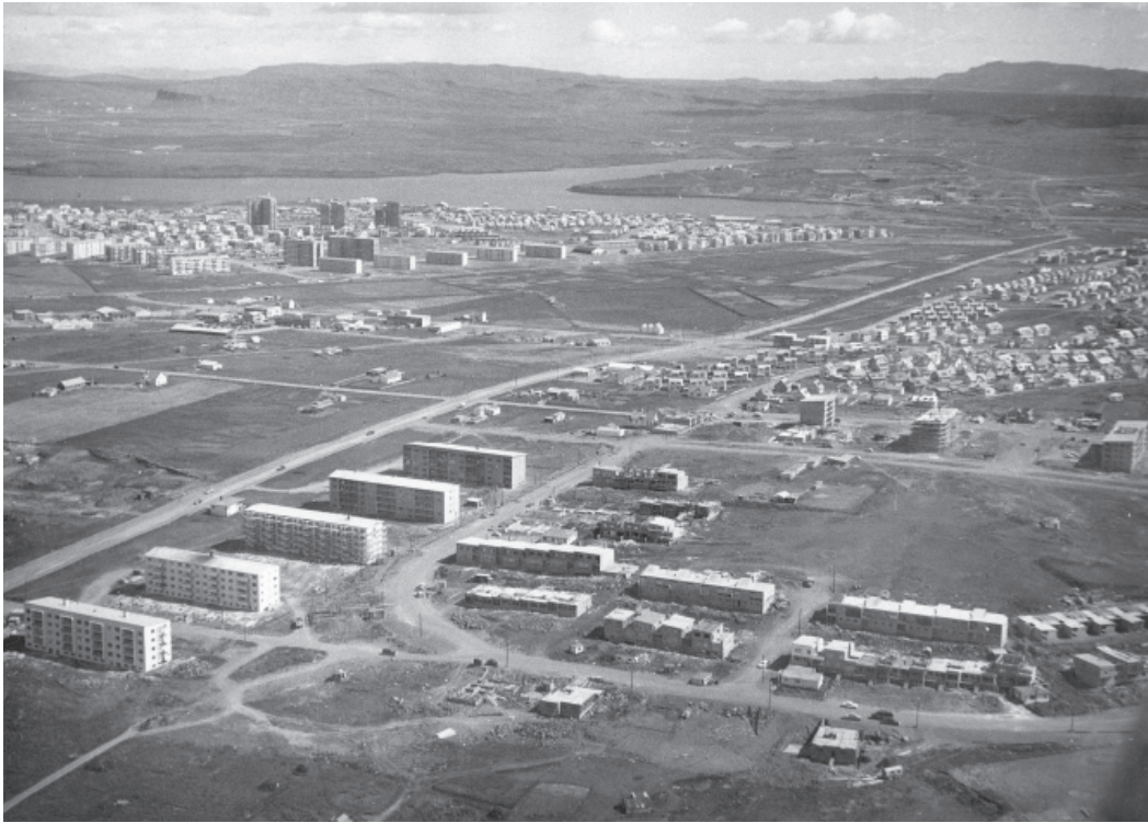
Hvassaleiti og Stóragerði í byggingu (Ljósmynd í eigu Ljósmyndasafns Reykjavíkur)
