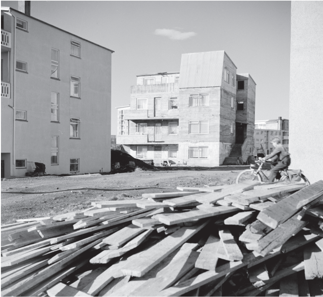
Nýbyggingar við Rauðalæk 1958 (Ljósmynd í eigu Ljósmyndasafns Reykjavíkur)
