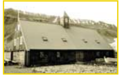
31. Turnhúsið í Ísafjarðarbæ. Ljósmynd. MS.
