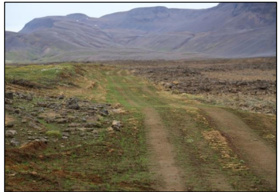
Mynd 7. Rofabarði ýtt niður á 3 km kafla við Mælifellsmóa og sáð í það með kastdreifingu á túnvingli og tilbúnum áburði.
