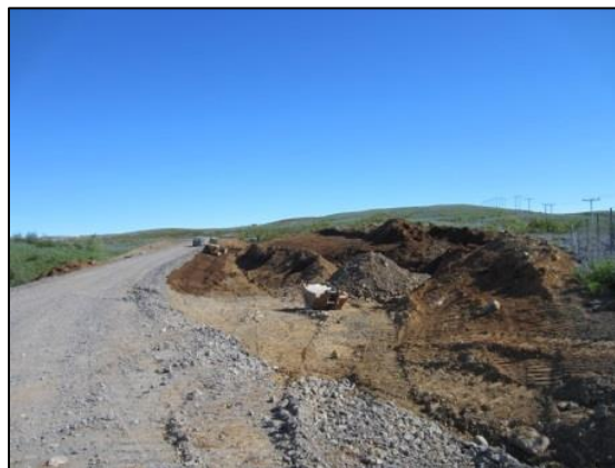
Mynd 1. Vegframkvæmdir við Þeistareykjavegnyrðri.
