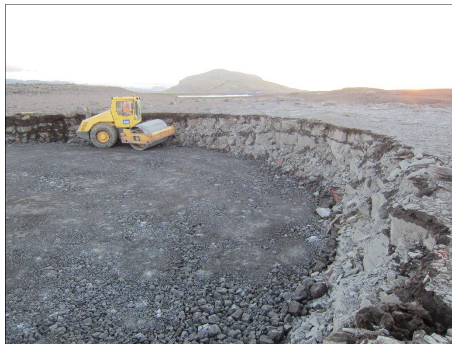
Mynd 3.3 Jarðvegsskipti og þjöppun lands fyrir undirstöður.
