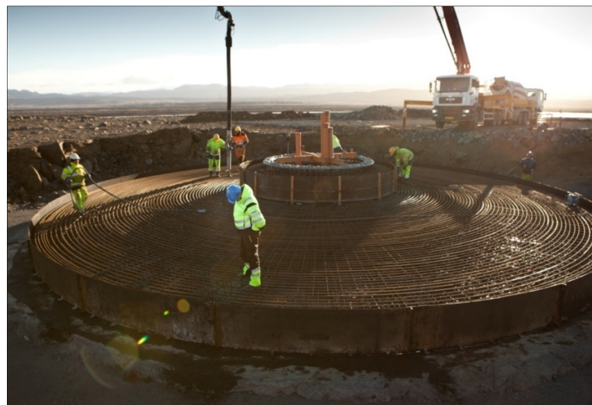
Mynd 3.4 Unnið að steypuvinnu fyrir undirstöður.
