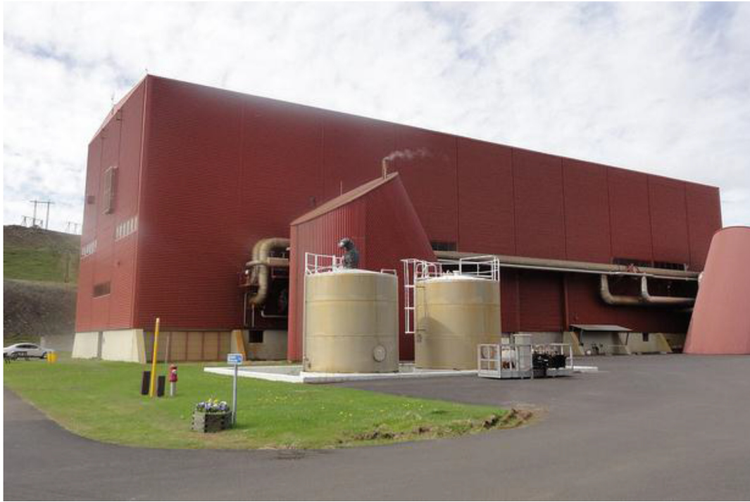
Mynd 14-3: Stöðvarhús Kröfluvirkjunnar.
