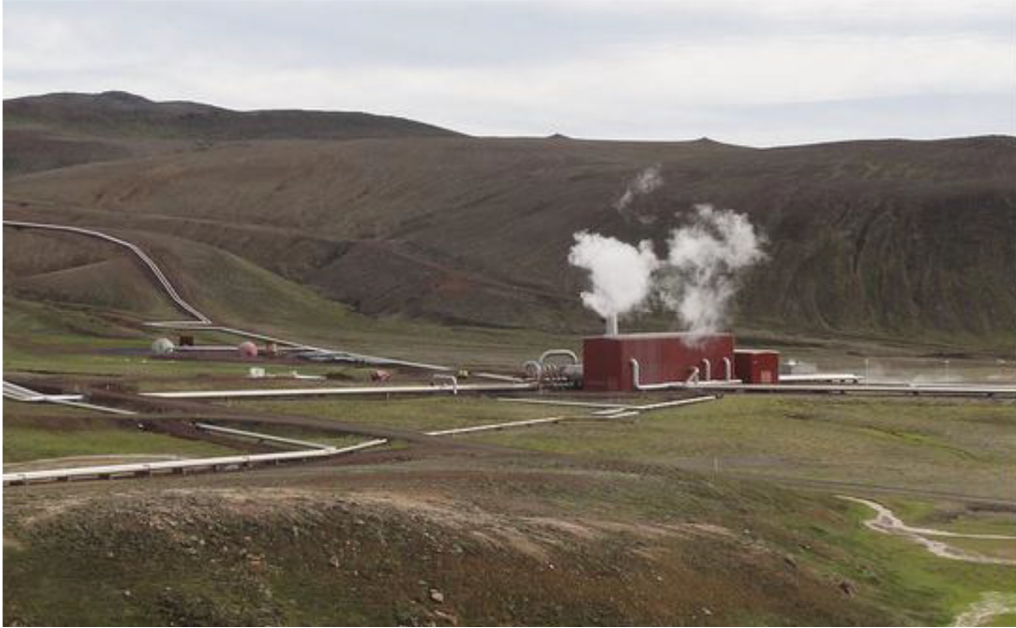
Mynd 14-2: Skiljustöð Kröfluvirkjunar og stofnæðar.
