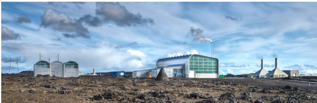
Mynd 18.2-1: Reykjanesvirkjun (HS Orka, 2014).
