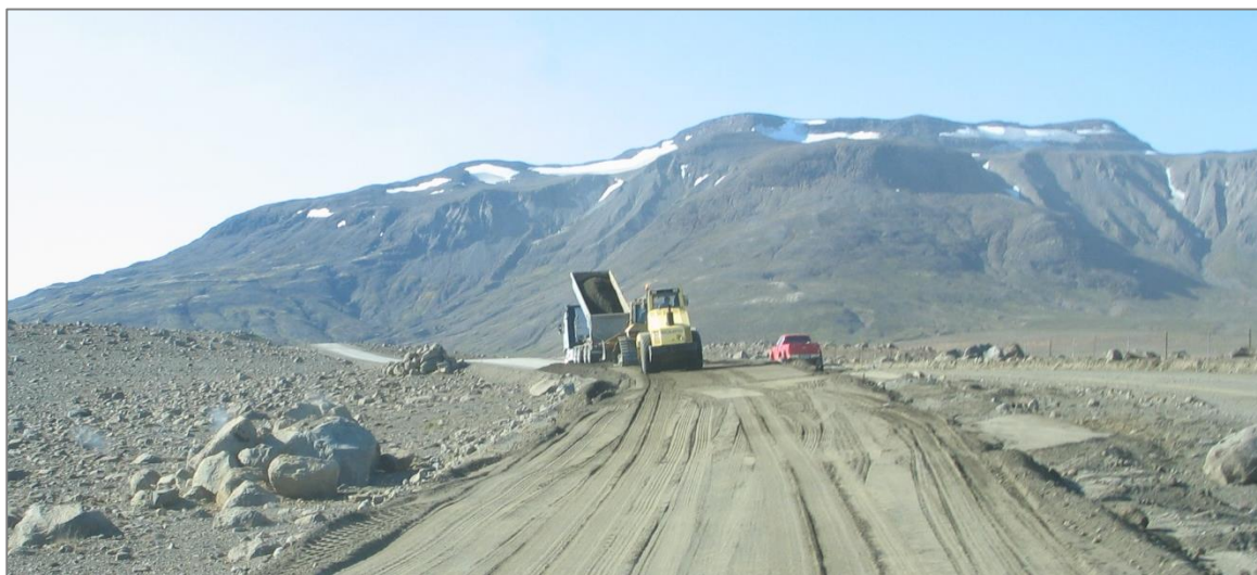
Mynd 10. Vegaframkvæmdir á Kjalvegi sumarið 2014 (mynd: Vegagerðin, 2014).
