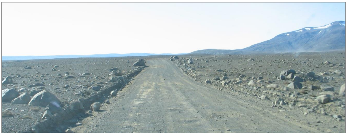
Mynd 3. Kjalvegur á fyrirhuguðum framkvæmdakafla (mynd: Vegagerðin, 2014).
