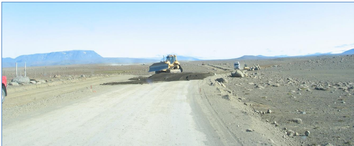
Mynd 19. Framkvæmdir á Kjalvegi sumarið 2014 (mynd: Vegagerðin, 2014).
