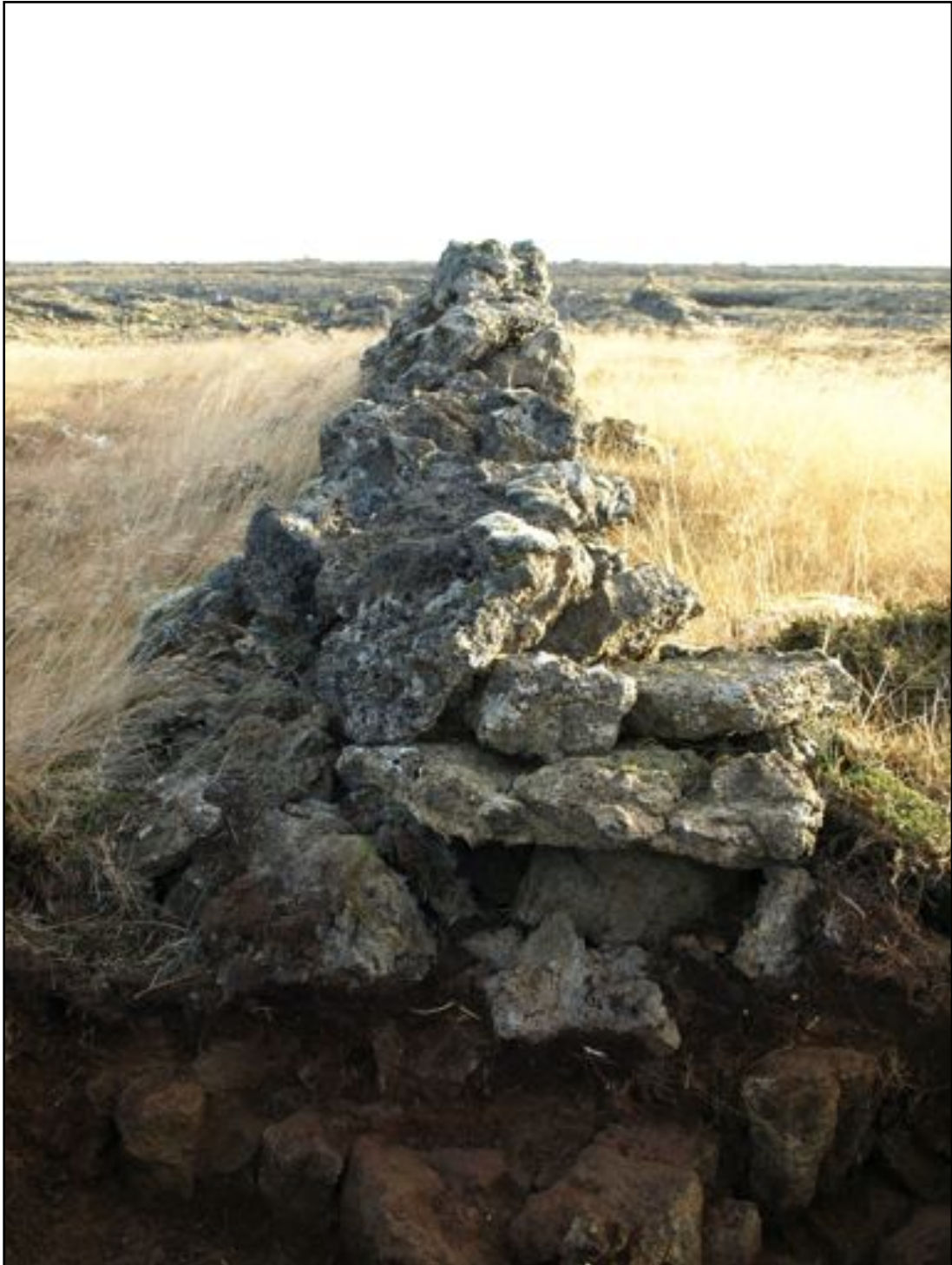
Mynd 4. Ljósmynd af sniðinu í túngarðinn. Neðst má sjá hraunhelluna og þar ofan á jarðlög. (Stafr. myndir nr. 14. Horft mót SSA. Ljósm. BFE).
