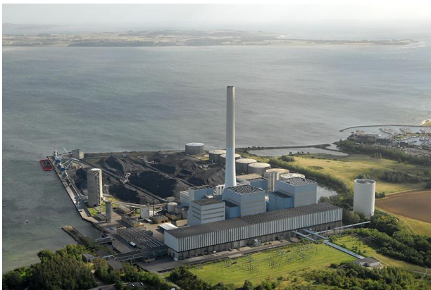
Figure 1: “Studstrupværket” power plant
