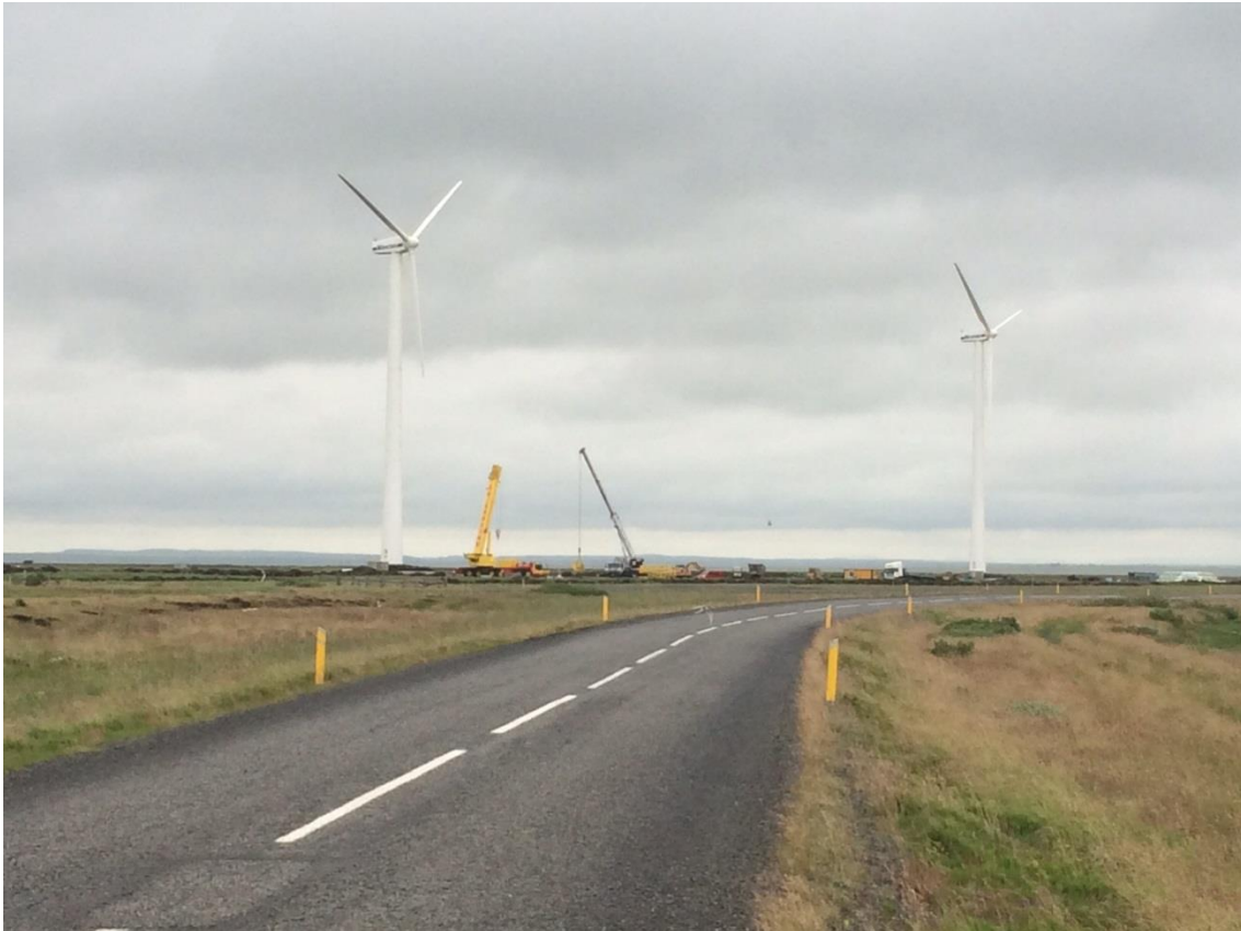
Mynd 4-3: Vindmyllur í Þykkvabæ.
