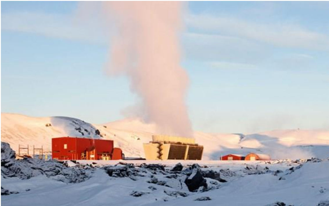
Mynd 18.2-1: Kröflustöð (Landsvirkjun, 2014).
