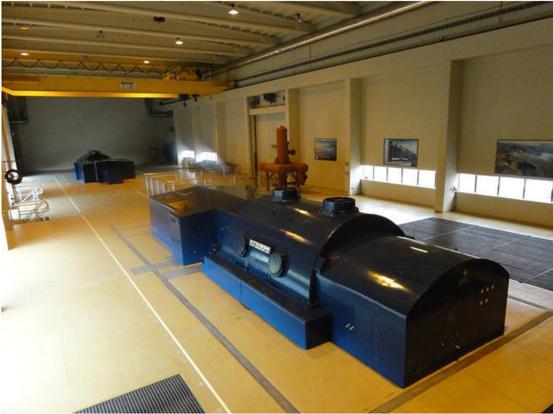
Mynd 15-1: Tveir 30 MWe hverflar Kröfluvirkjunar.
