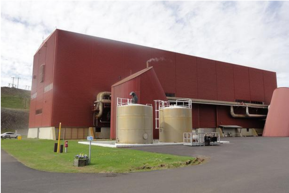
Mynd 14-3: Stöðvarhús Kröfluvirkjunar.
