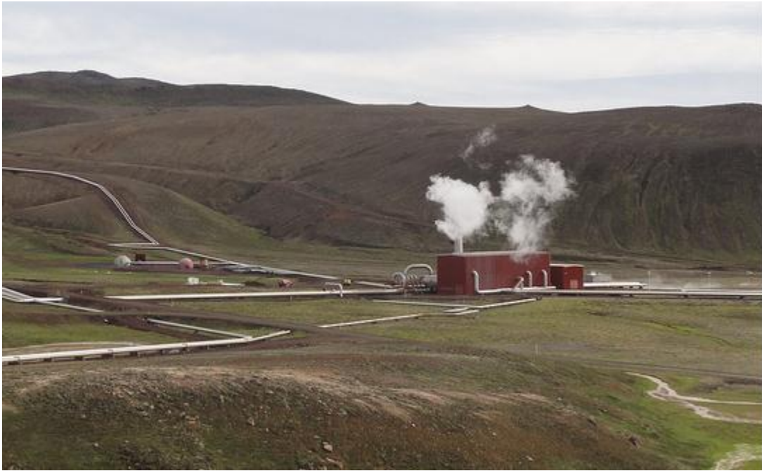
Mynd 14-2: Skiljustöð Kröfluvirkjunar og stofnæðar.
