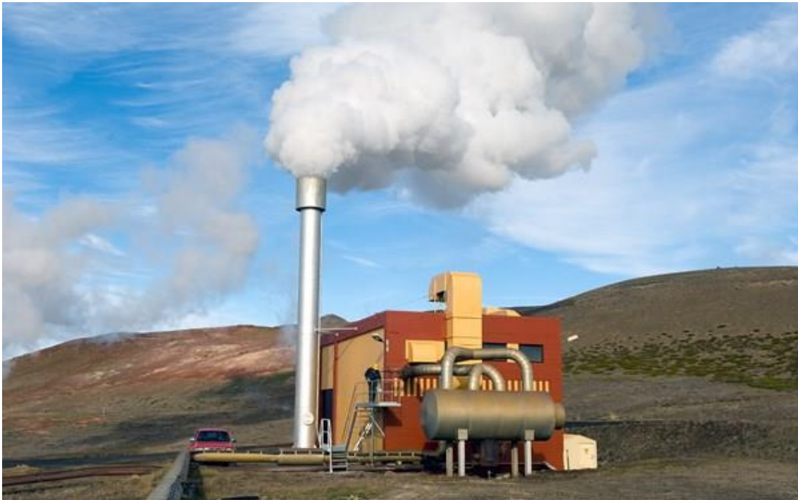
Mynd 18.2-1: Núverandi jarðgufustöð í Bjarnarflagi (Landsvirkjun, 2014).
