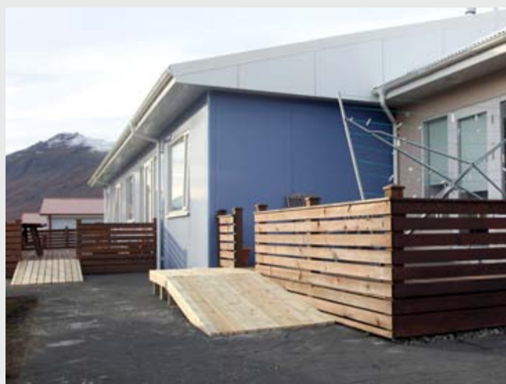
Hérna er búid að leggja stéttina og smíða rampana fyrir hjólastólana. Eftir er að setja trékanta og ryðfrítt stál á brúnir rampanna.
