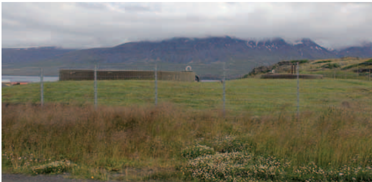
Aðal safnþró Vatnsveitu Vopnafjarðar. Brunnurinn er einn af nokkrum í fjallinu en þeir eru allir innan girðingar.
