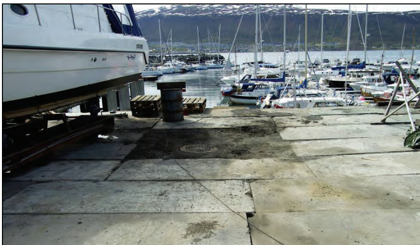
Figur 12. Støpte betongheller, skrånende mot oppsamlingskum for spylevann på slipp N3.
