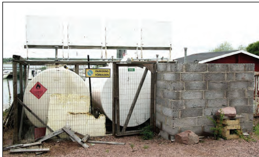
Figur 31. Oppsamlingstanker for olje og for annet flytende avfall på slipp Å1 3.
