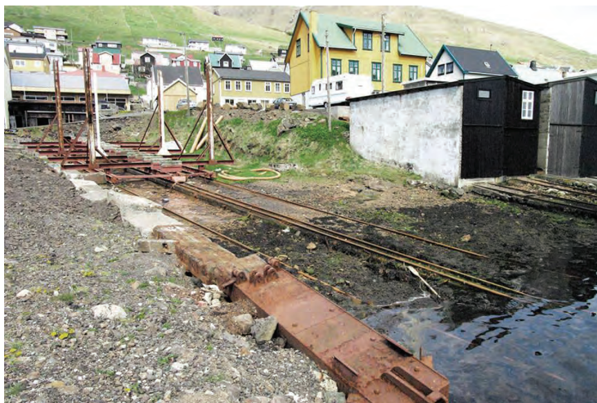
Figur 46. Skinnegående vugge på naturgrunn på slipp F3.
