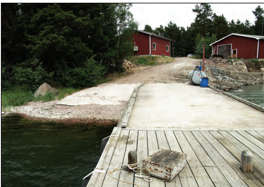
Figur 21. Kai og plattform for oppsett av båter på vogn med hjul på slipp Å 2.
