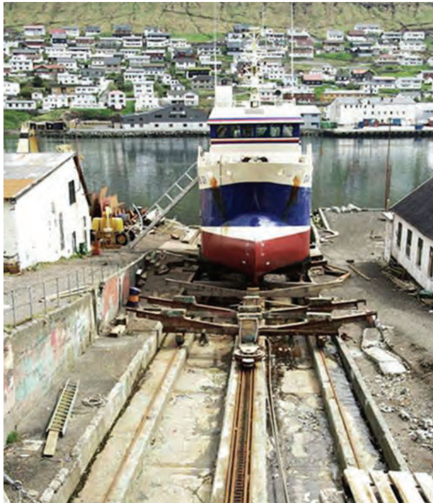
Figur 43. Vugge på skinner plassert i ei helstøpt renne (betong)
