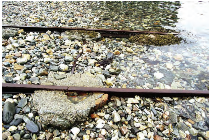
Figur 3. Skinnene i opphalet er fundamentert med betong. Tangbevokst stein i fjæra.
