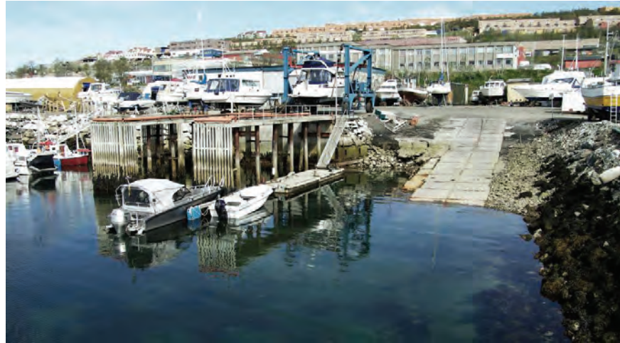
Figur 10. Slipp N3 har to system for opptak av båter; vogn med løftestropp, og plattform for oppdrag ved hjulgående vugge dratt av hjullaster.
