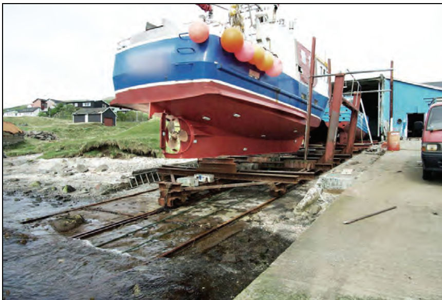
Figur 34. Slipp F 1: Vugge på skinner over betongplattform.
