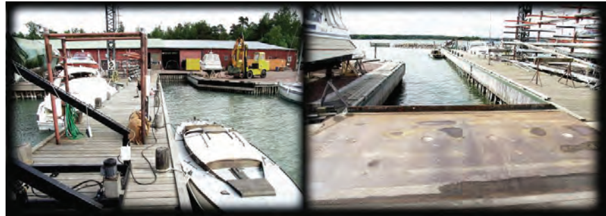
Figur 26. Kai/sluse for opptak av båter med masttruck på slipp Å 3.
