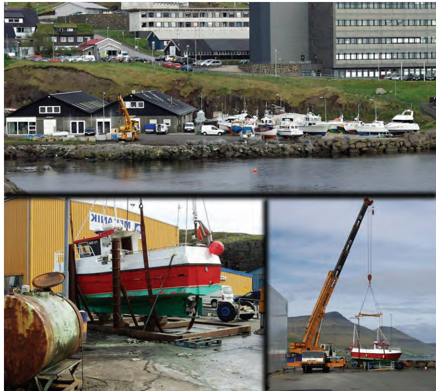
Figur 38. Eksempler på oppsett på kai med mobil kran.
