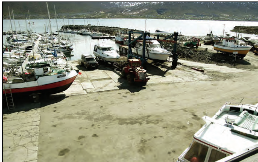
Figur 11. Oversikt over oppsett av båter for slipp N3.
