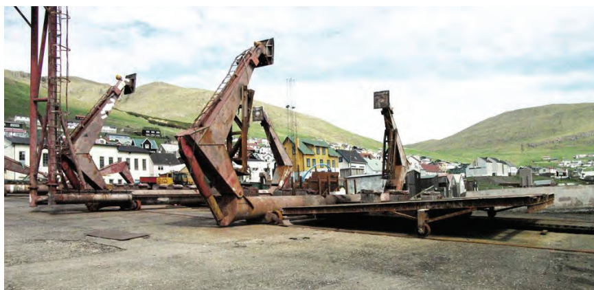
Figur 45. Skinnegående vugge på helstøpt plattform på slipp F3.
