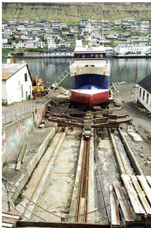
Mynd 43. Grind á teinum á heilsteyptri braut (sement)
