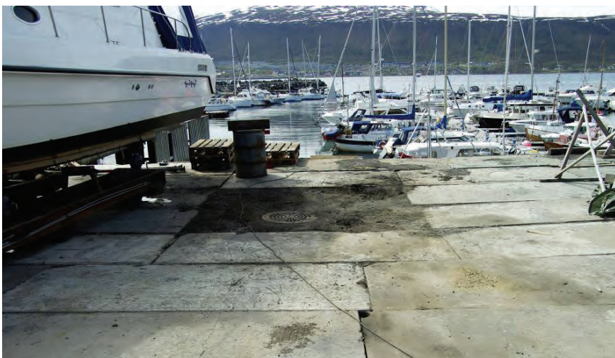
Mynd 12. Hellulagt planið á slip pstöð N3 hallar niður að skál með botnsfallsfrou ði fyrir frárennsli.
