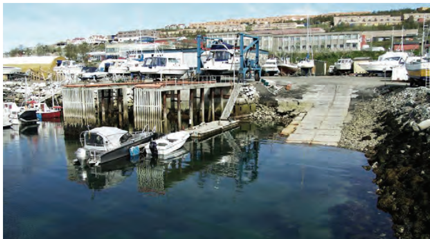
Mynd 10. Á slippstöð N3 er tvíveggja konar búnaður til að taka báta á land; grind með lyftitaug og pallur þar sem dráttarvél dregur grind á hjólum.
