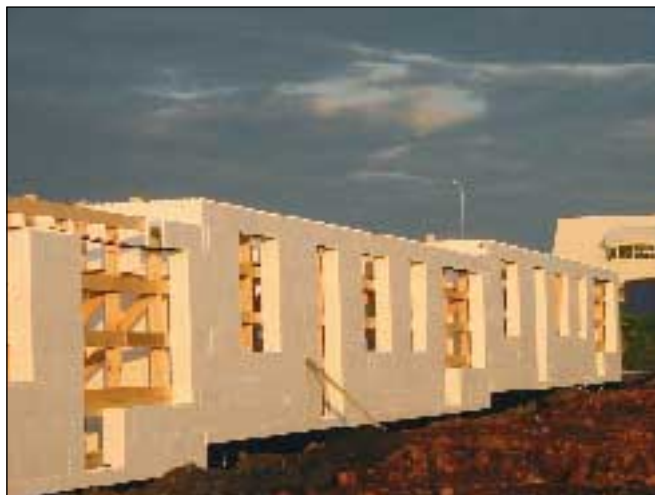
Raðhús í byggingu í Reykjanesba
