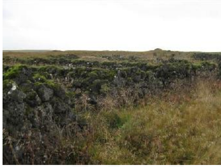
Veggur í suðurhluta Dælaréttar 009.
