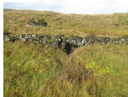
Brú 019, horft til VNV.
