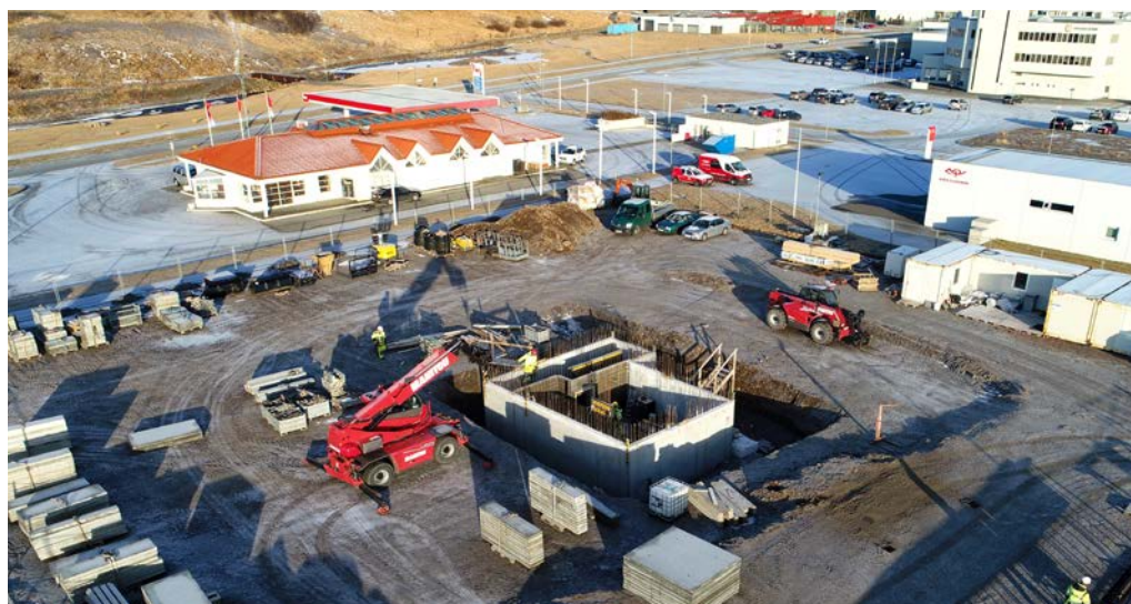
FRAMKVÆMDIR VIÐ NÝBYGGINGU BYGGÐASTOFNUNAR Á SAUÐÁRKRÓKI
